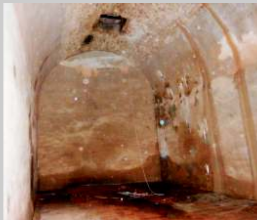
FOTO 3: interno della cisterna realizzata da mastro Tommaso da Bellinzona (1460-1469) al di sotto della piazza san Giovanni (l'apertura in alto corrisponde al pozzo esterno)
