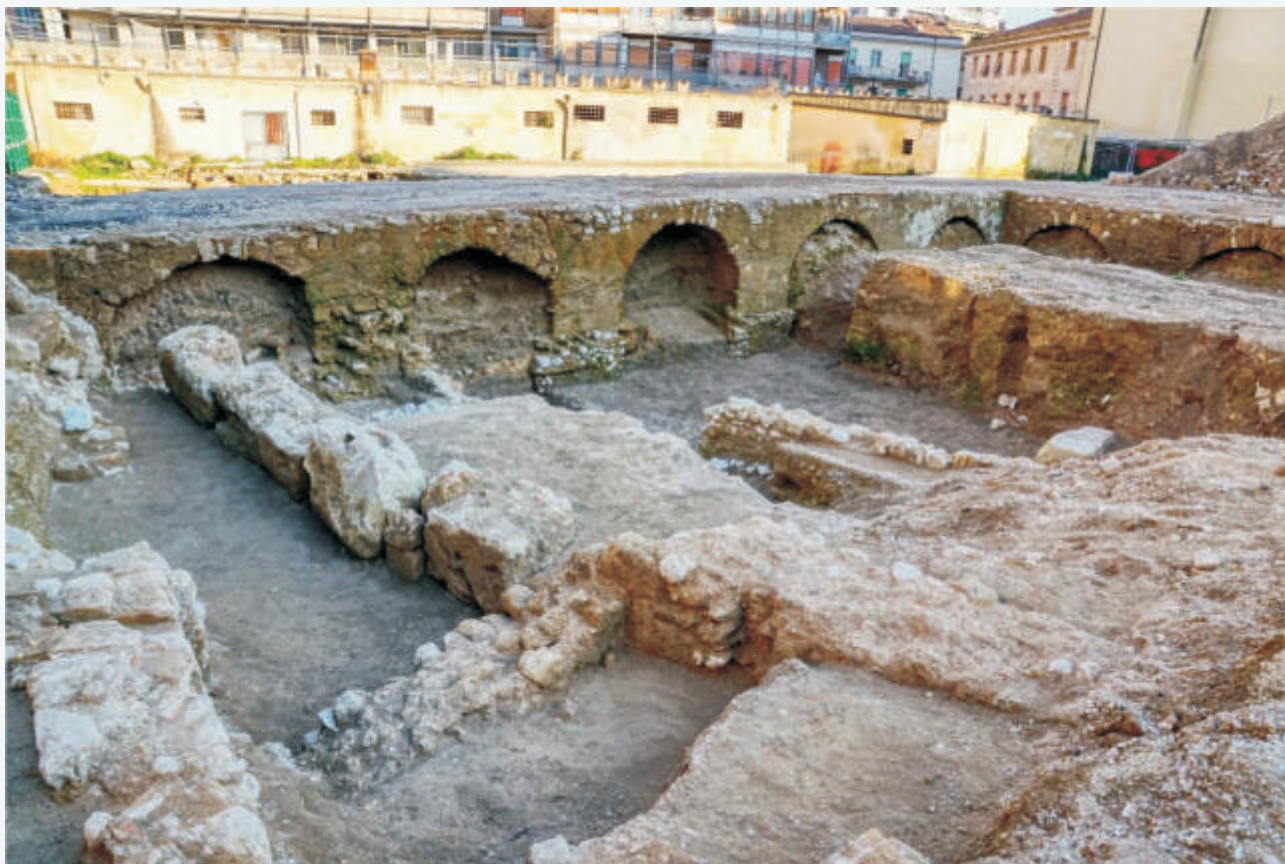
Fig. 8. Le strutture fondali ad arco nell'angolo Sud - Est del chiostro. In primo piano le strutture medievali e i grandi blocchi di riuso.
