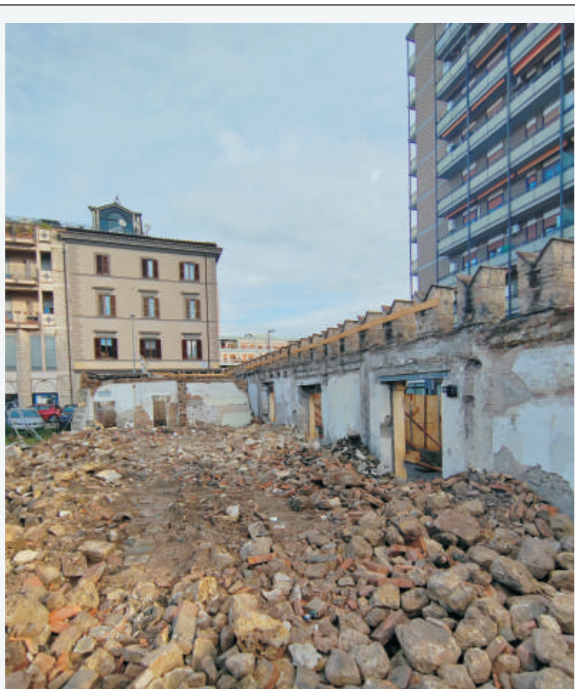
Fig. 4. La demolizione degli edifici in muratura a un piano realizzati in aderenza alle mura merlate ottocentesche dopo la seconda Guerra Mondiale.
