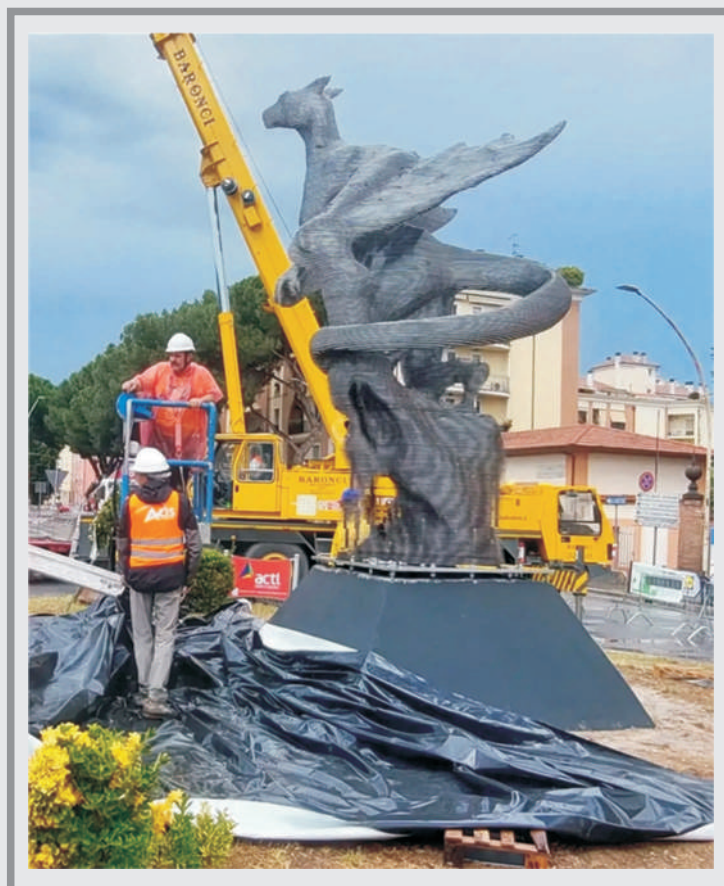
Il montaggio in opera del drago di Terni
