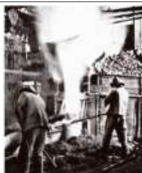
Fig. 2 Forni del carburo.
