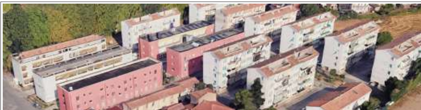
Foto aerea di tutto il quartiere oggetto dell'intervento con, a sinistra, i tre edifici da demolire.
