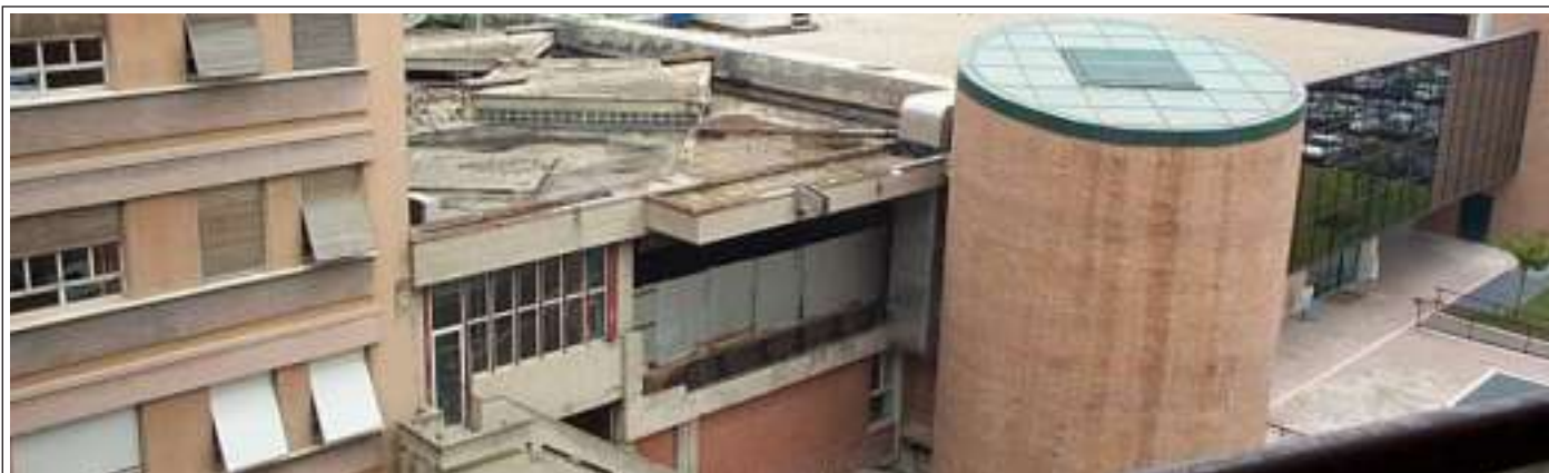
Un'immagine del 2001 che mostra la zona di attacco del nuovo blocco DEA, ormai praticamente ultimato, con il vecchio corpo centrale ospedaliero mediante l'inglobamento dell'originario viadotto in c.a. di pronto soccorso-accettazione.
