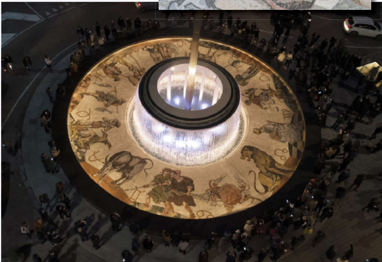
I lavori di restauro effettuati recentemente dalla Fondazione ai mosaici di Corrado Cagli per la rinascita della fontana dello zodiaco a piazza Tacito.
