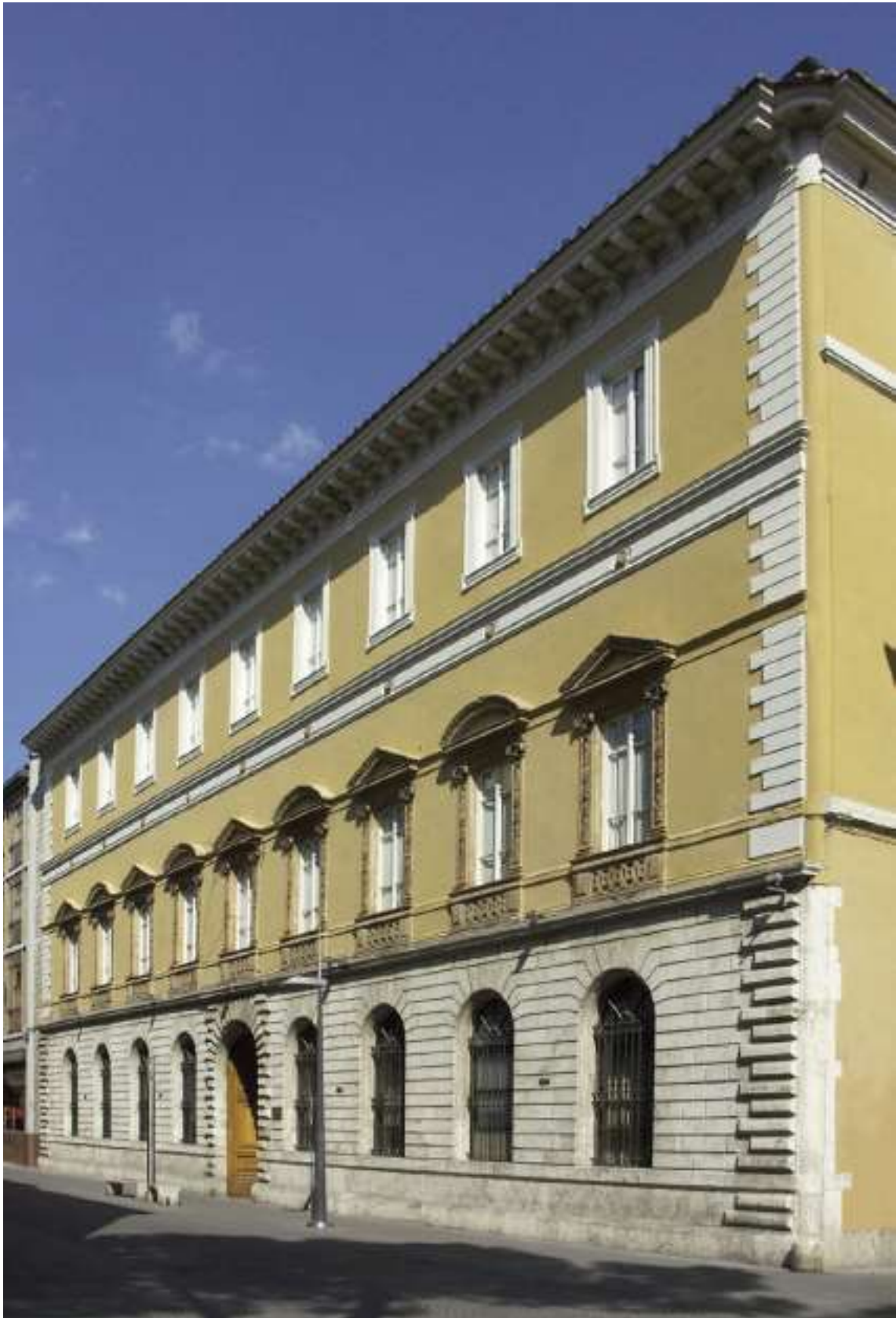
La facciata su corso Tacito del palazzo Montani Leoni, sede della Fondazione CARIT
