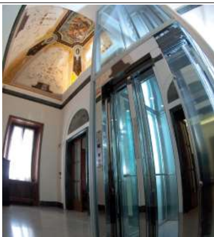
Un aspetto dell'atrio con l'antica volta settecentesca "riapparsa" durante i lavori del nuovo ascensore
