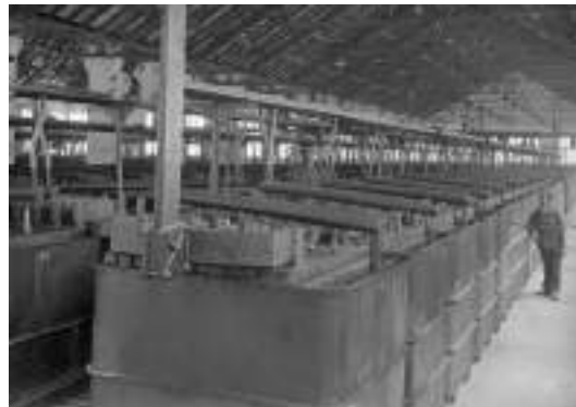
Da sinistra, la sala di catalisi e la sala degli elettrolizzatori dello stabilimento di Sabinanigo, in Spagna (Archivio di Stato di Terni, Archivio SIRI, b. 704).
