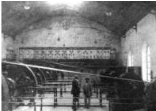
La sala dei compressori e delle pompe di circolazione nell'impianto della SIAS installato all'interno dell'ex Ferriera di Terni all'inizio degli anni venti (Archivio Fabi).
