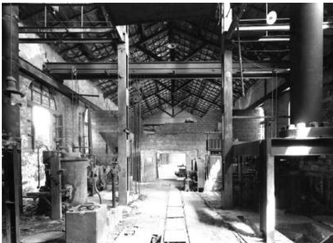
A sinistra e al centro: gli interni del reparto I 100 della SIRI, demolito nel 1990, con i tubi di sintesi (Servizio Musei e Beni Culturali della Regione dell'Umbria).
