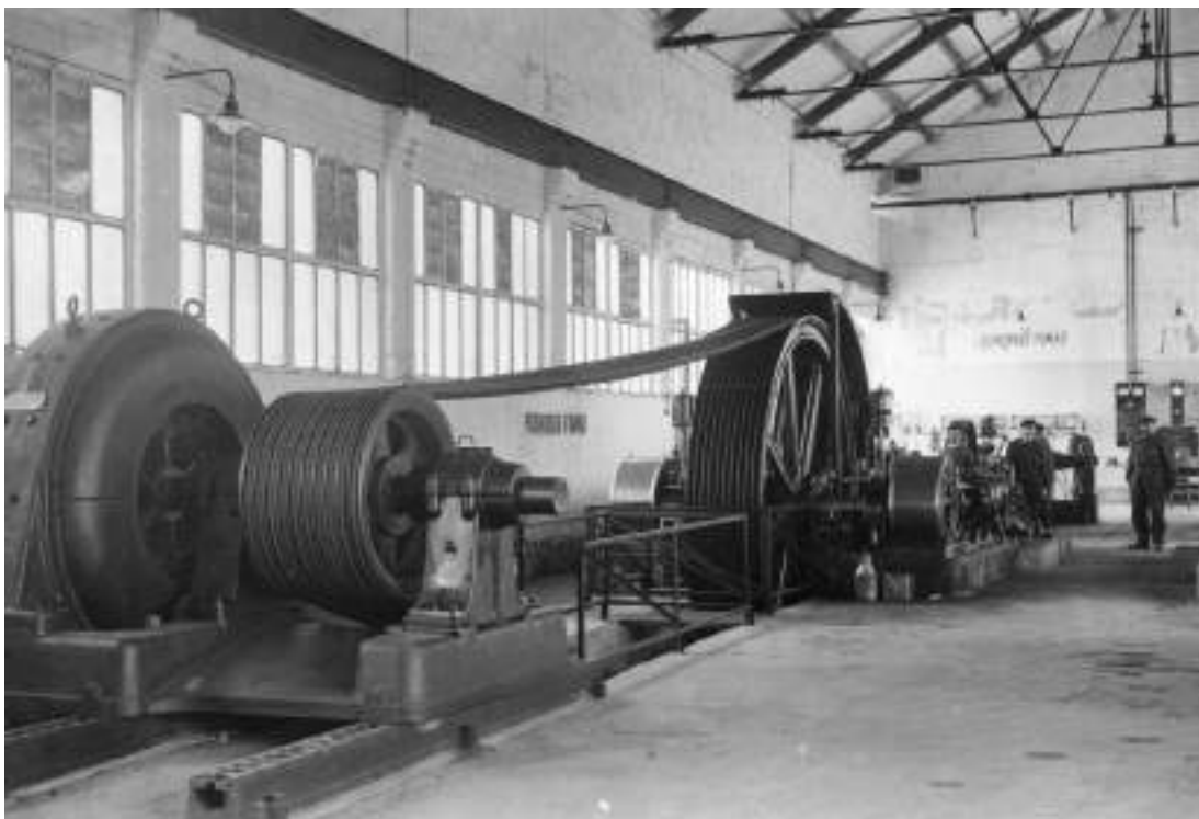
Uno dei compressori dello stabilimento di Sabinanigo, in Spagna (Archivio di Stato di Terni, Archivio SIRI, b. 704).
