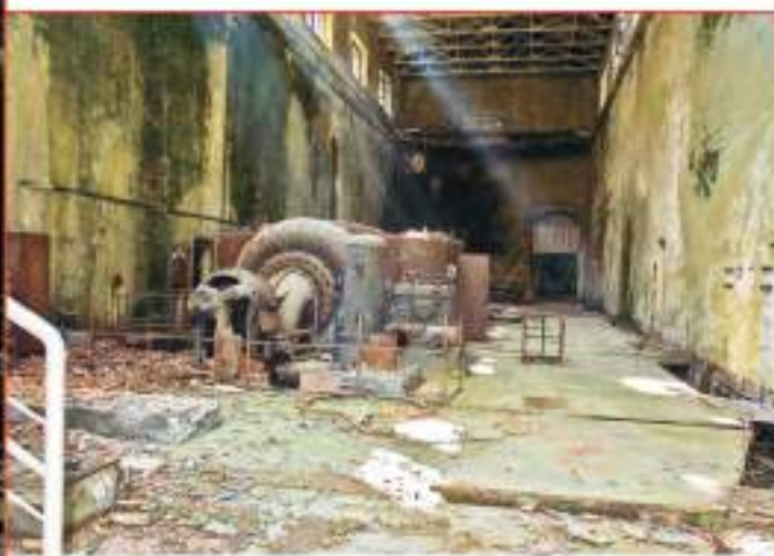
Lo stato attuale dei bracci della centrale (sala Velino).
