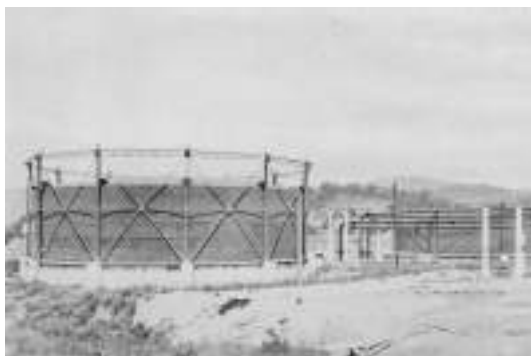
I gazometri dell'idrogeno e della miscela (a), punto 5 dello schema.
