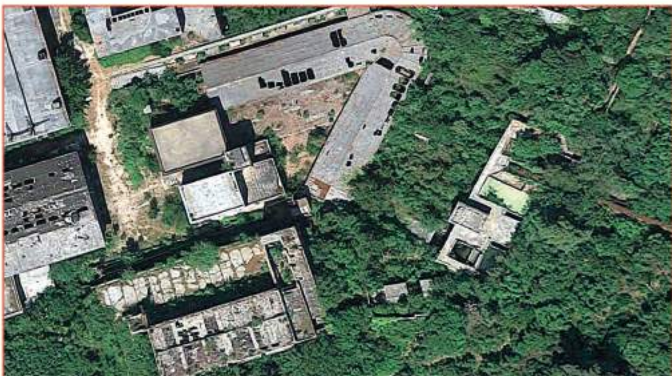
Dettaglio dell'area delle vecchie centrali che mostra, al centro, la copertura degradata della storica centrale Velino-Pennarossa con la caratteristica forma planimetrica a "V".
