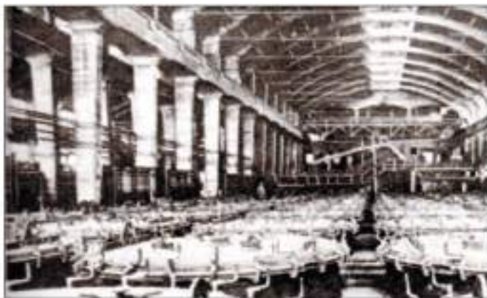
La grande sala di azotazione (oggi parte degli studi cinematografici). Ecco in proposito la descrizione di Gadda (da "Azoto atmosferico tramutato in pane" )
