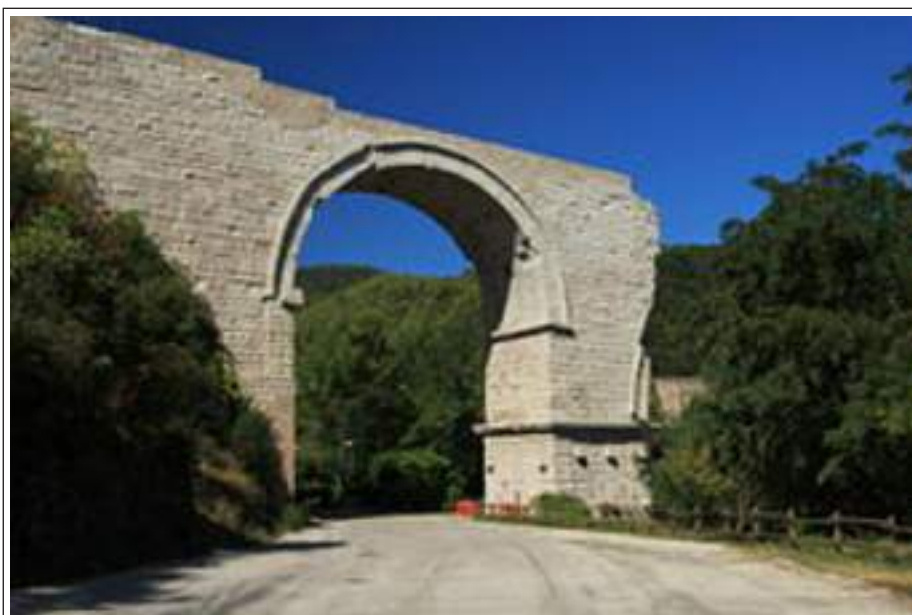
Figura 1: La spinta dell'arco dell'antico Ponte di Augusto a Narni è stata contrastata con tiranti in titanio.
