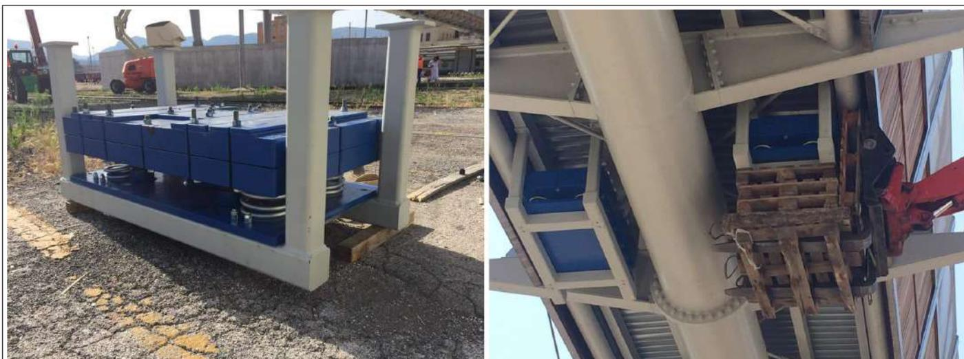
Smorzatori a massa accordata (TMD) a piè d'opera e in fase d'installazione
