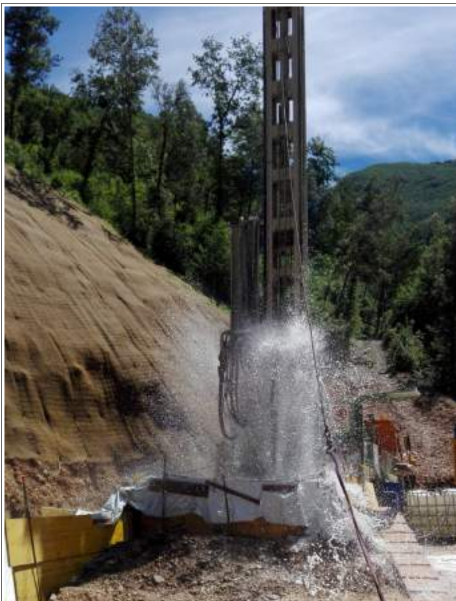
Fase di captazione della falda sotterranea durante la realizzazione del pozzo n°1
