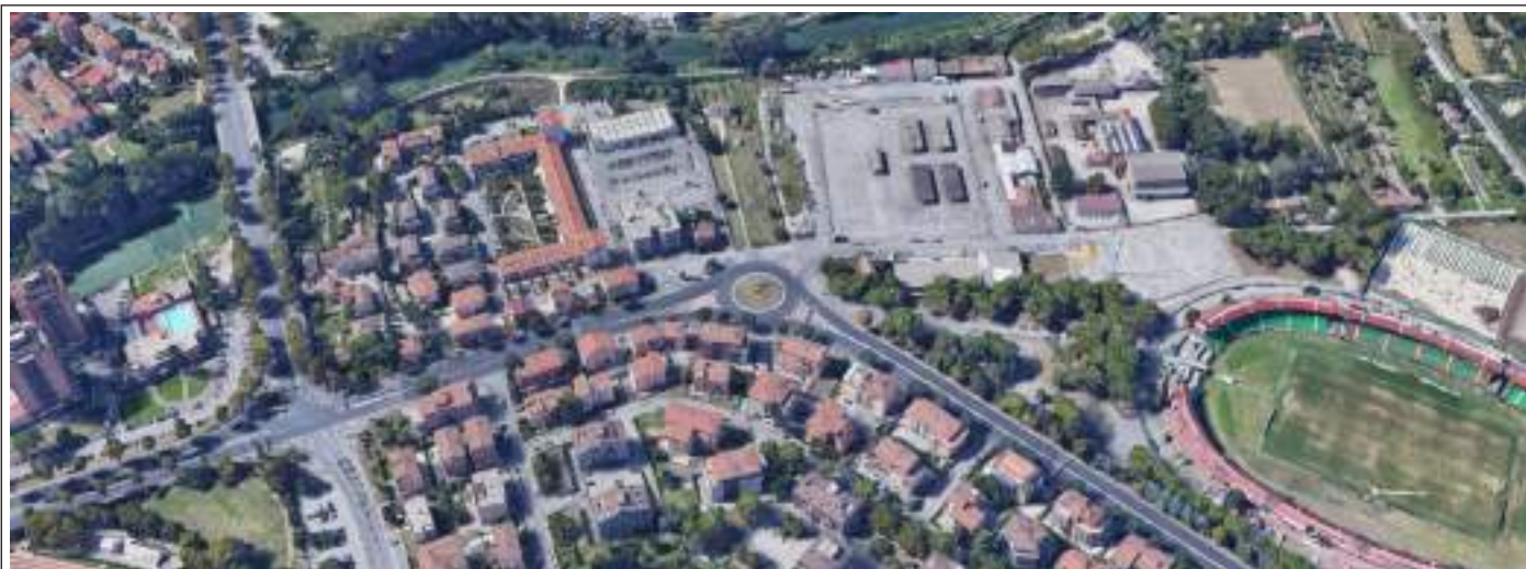
Foto aerea della zona dell'ex foro boario a ridosso del fiume Nera dove sorgerà il nuovo PalaTerni tra l'asta di ponte Allende (a sinistra) e lo stadio (a destra).
