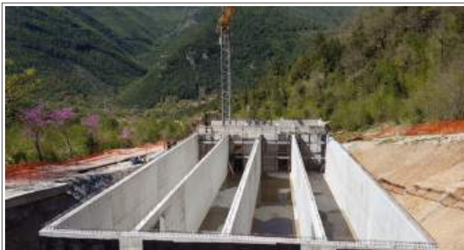
Fase di realizzazione del serbatoio di compenso in loc. Terria
