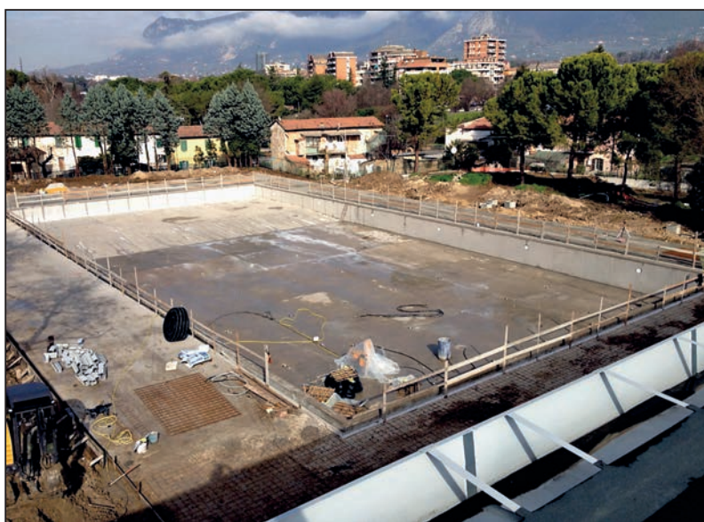
• Una panoramica dei lavori alla piscina scoperta olimpionica da 50 metri
