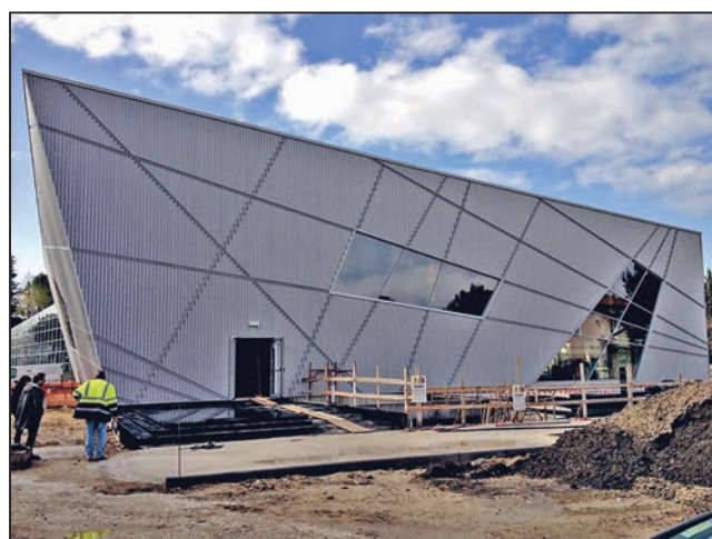
• La piscina coperta vista dal lato di via Pettini
