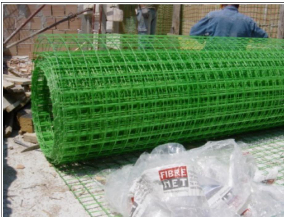
*un rotolo in fibra di vetro per la realizzazione di intonaci di calce strutturali e termo-isolanti.*
