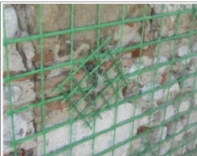
*Dettaglio del connettore trasversale realizzato con una barra in vetroresina e collegato alla rete dell'intonaco armato, infittita localmente per meglio distribuire la sollecitazioni.*
