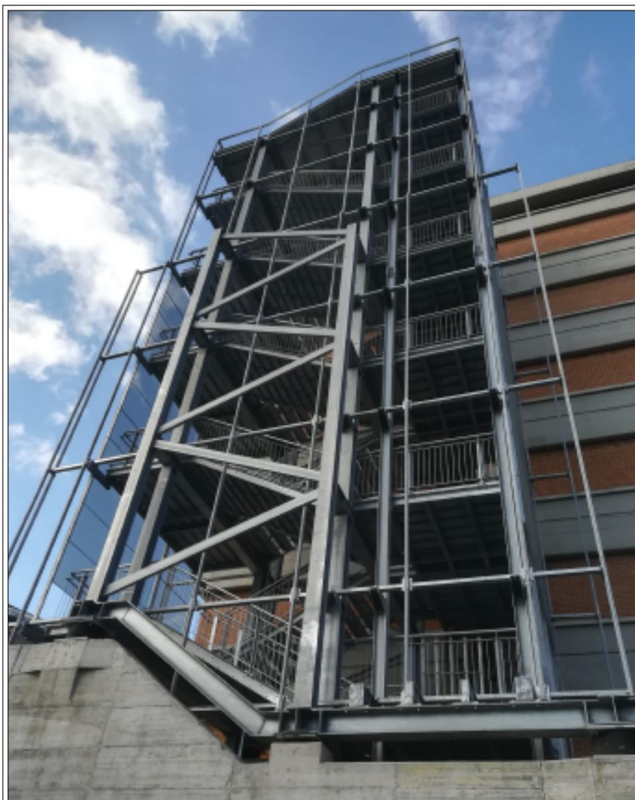
*la scala S2 in fase di realizzazione: sopra il profilo del calcestruzzo i due isolatori e la slitta sul baggiolo al centro; si noti la baraccatura per il sostegno dei pannelli in corten e di quelli microforati*
