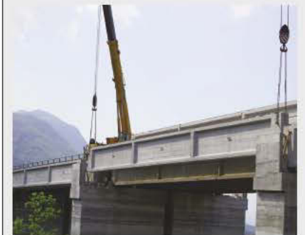
Fig.4: Alcune fasi di realizzazione dell'opera
