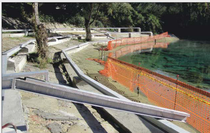
La Mole: Realizzazione struttura di sostegno di piattaforma di nuova costruzione
