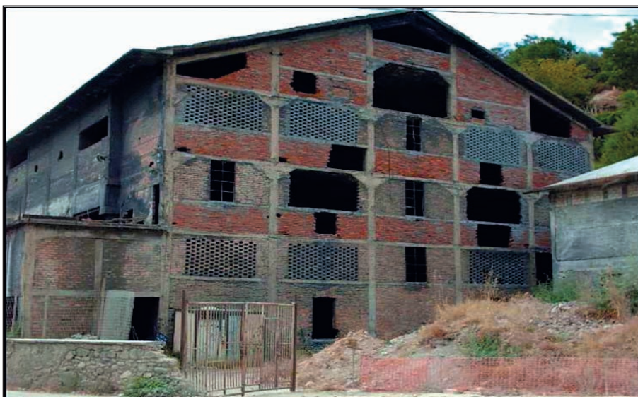
Figura 2 - Deposito di calciocianamide, fronte Est
