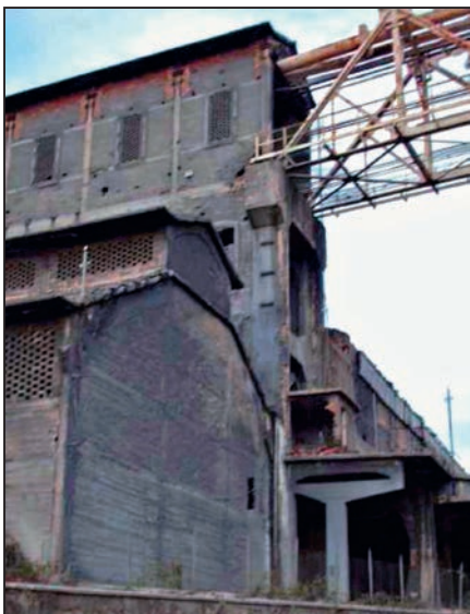
Figura 6 - Passerella Telfer (lato deposito calciocianamide) e spogliatoio Villa Valle
