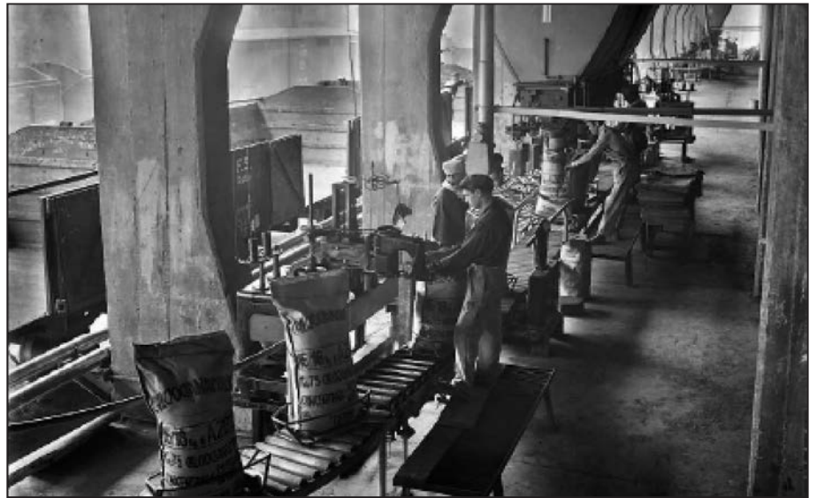
Figura 5 - Insaccamento-Passaggio dei sacchi nella zona del porticato esterno al deposito e loro riempimento con calciocianamide
