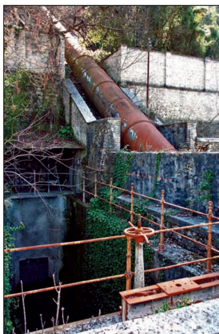
Lo stato attuale (a sinistra) delle antiche condotte che dalla cascata raggiungevano la centrale idroelettrica di “Velino-Penna Rossa” (a destra una sezione del primo novecento).
