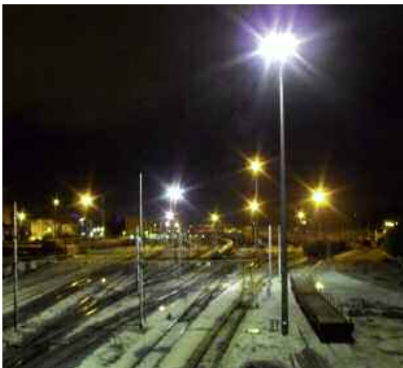
Terni Stazione FS.SS - Vecchie torri-faro con proiettori asimmetrici Diffondono la luce verso l'alto, illuminano male, abbagliano gli occhi, sprecano energia. Sono veri e propri "mostri"
