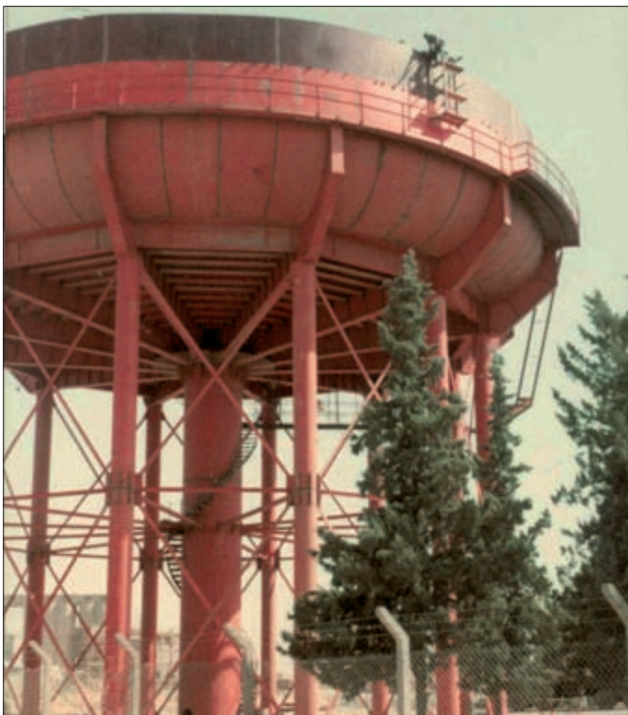
Serbatoio ad Arbil in Iraq (foto del maggio 1978)
