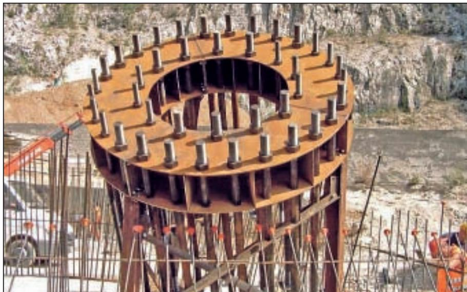
La dima di ancoraggio dell'arco da 165 m con diametro 3 m
