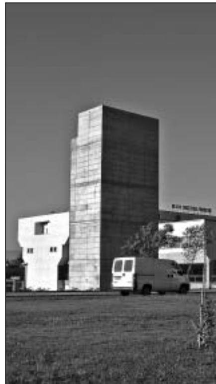
La nuova sede dei vigili del fuoco in via Proietti-Divi a Terni
