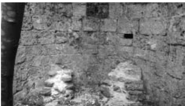
I resti dell'altare demolito
