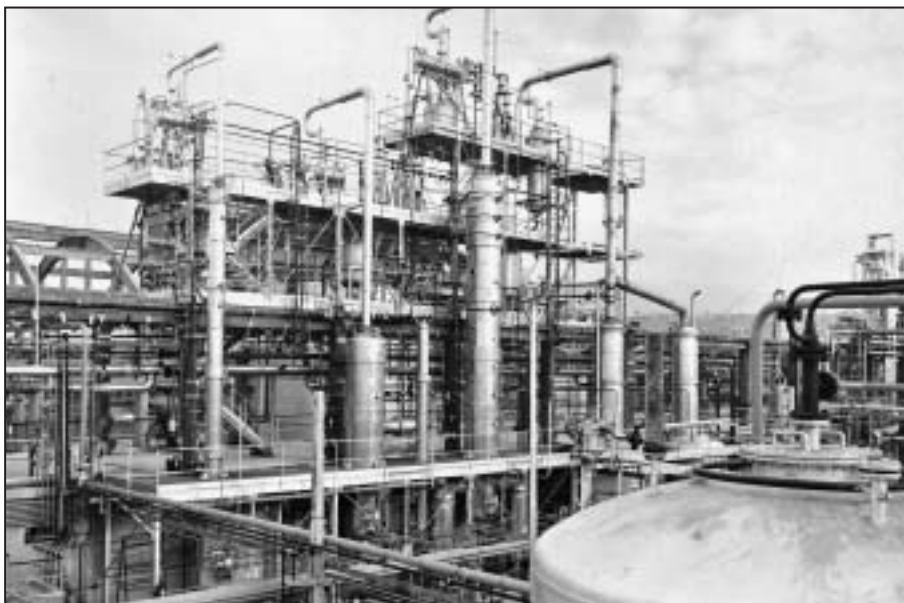
Impianti di polimerizzazione del polipropilene.
