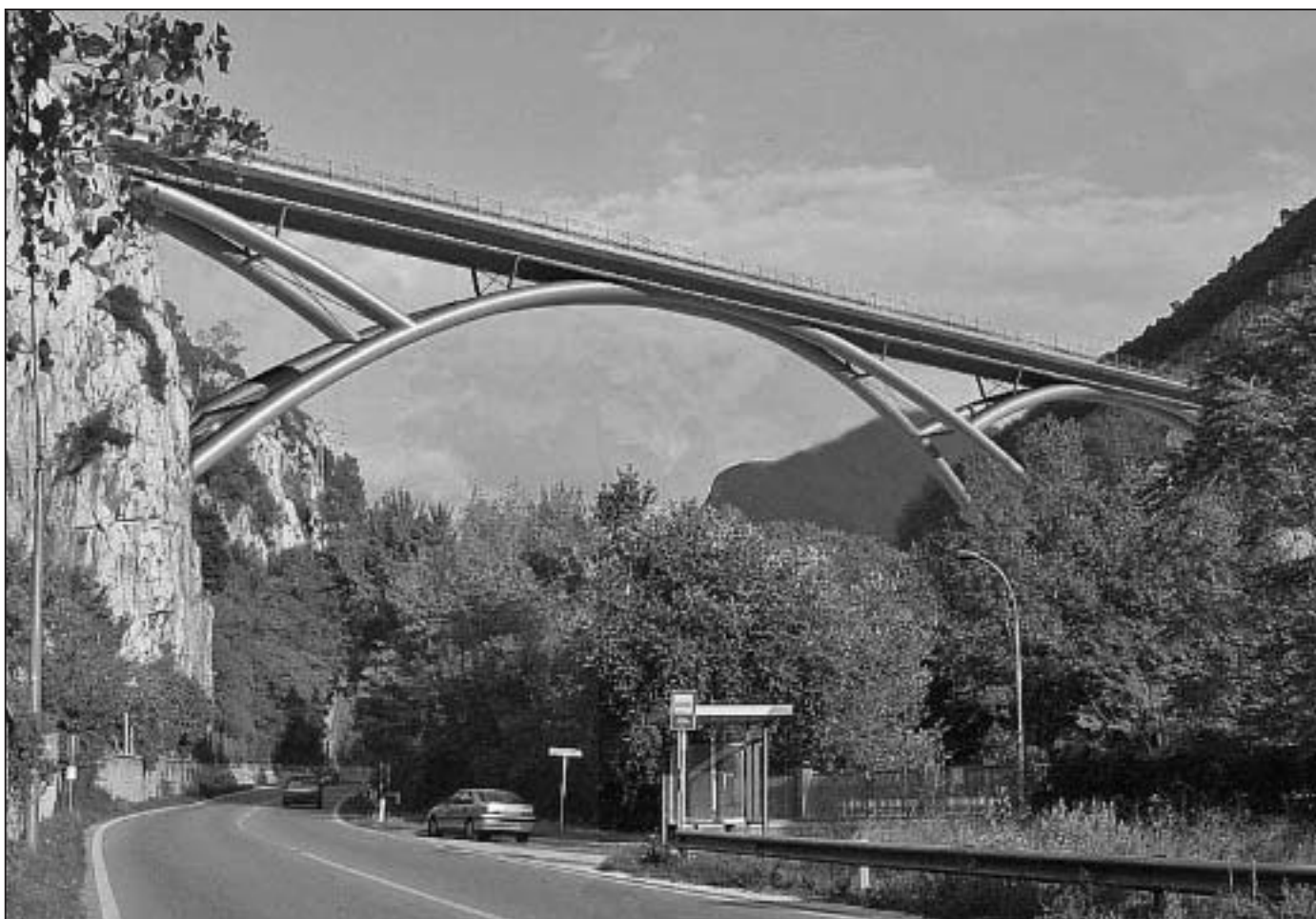
Il futuro ponte sulla Valnerina nei pressi della cascata.
