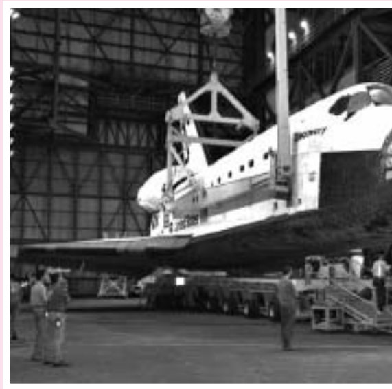
Lo shuttle viene imbracato per essere sollevato nel sembraggio verticale (VAB)
