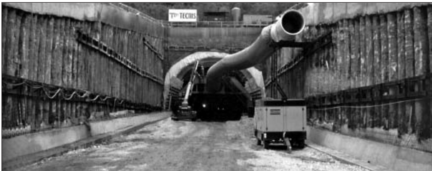
I lavori in galleria
