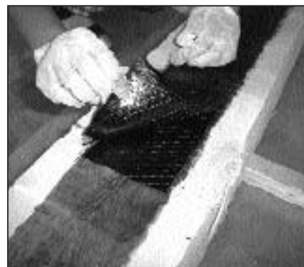
Fig. 2: L'applicazione del nastro in composito su una trave lignea
