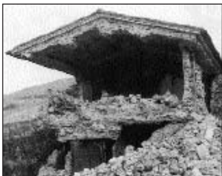
Fig. 1: Un caso in cui la sostituzione di solai in legno in edifici realizzati con murature storiche può determinare un peggioramento della vulnerabilità sismica
