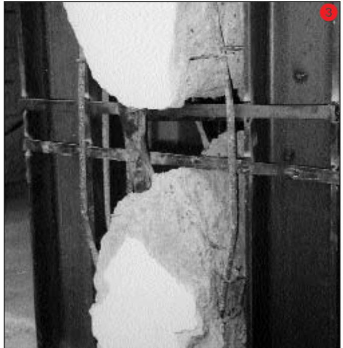
*Scura (Acireale) – Apertura delle staffe, instabilità delle barre longitudinali, espulsione completa del nucleo di calcestruzzo, elementi provvisori in acciaio disposti dai V.V.F. per evitare il crollo dell'edificio.*
