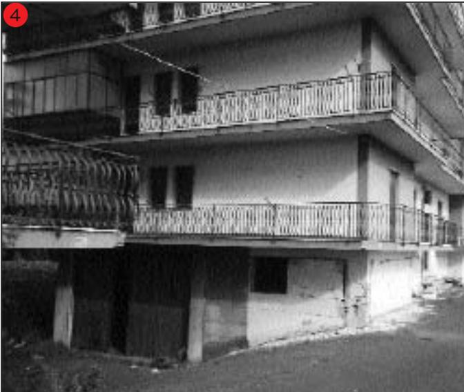
*Felicetto (S. Venerina) – Pilastro corto di lunghezza di circa un metro, con elevata componente tagliante della sollecitazione non contrastata per le ridotte dimensioni dell'area resistente e la scarsa presenza di armatura trasversale.*
