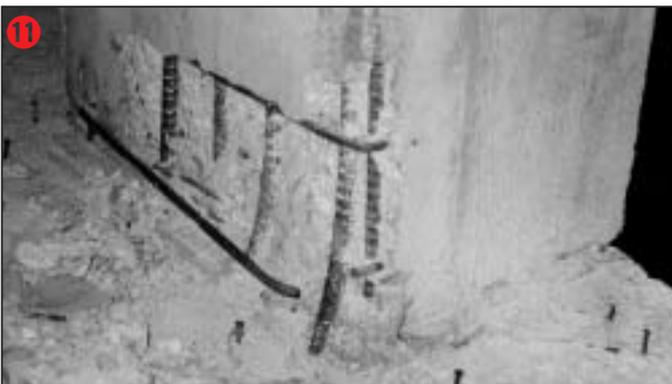
11 S. Giuliano di Puglia – Notevole disuniformità di rigidezza in elevazione. Danni in quasi tutti i nodi trave-pilastro, in corrispondenza del primo livello fuori terra, completamente pilotis, con espulsione del copriferro, rottura di alcune staffe e instabilità delle barre longitudinali.
