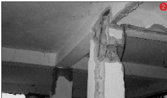
*Lipara (S. Venerina) – Completa assenza di armatura trasversale, espulsione del copriferro e del nucleo centrale di calcestruzzo, instabilità delle barre longitudinali, spostamento relativo fra i due monconi del pilastro.*
