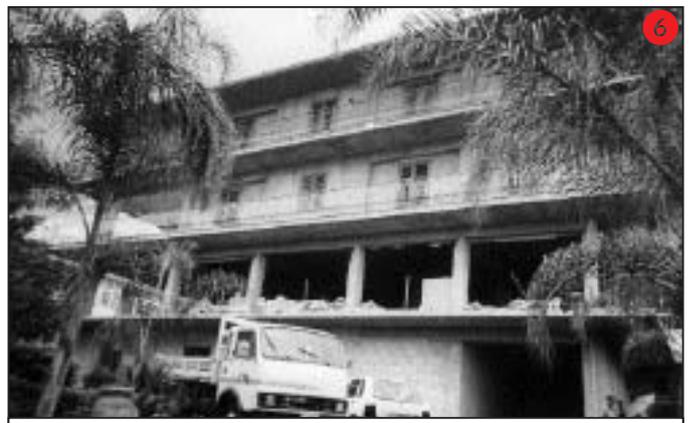
*Guardia (Acireale) – Formazione di un completo piano pilotis in corrispondenza del piano con tamponature di elevata rigidezza, ma di minore resistenza (laterizio forato, disposto in foglio, a doppio paramento), rispetto al piano inferiore (blocchetti in Cls).*
