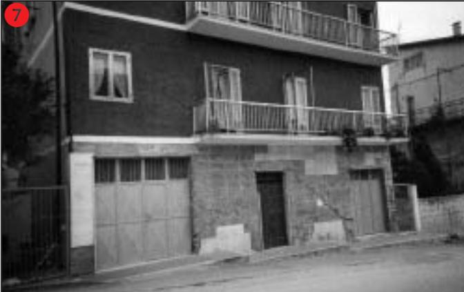
7 S. Giuliano di Puglia – Le aperture non sono allineate in altezza e nel prospetto principale si notano vaste aperture al piano terra in corrispondenza dei maschi murari superiori, lesioni di taglio nei maschi murari del piano terra e del piano primo.
