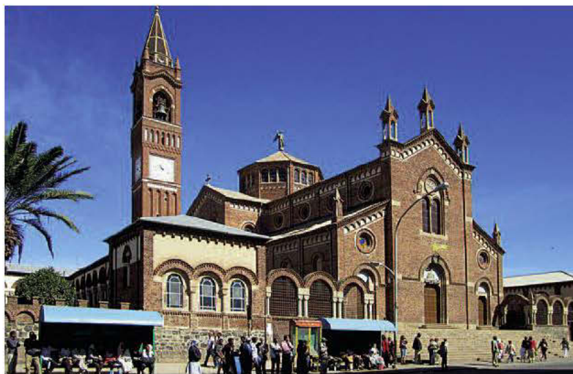
La cattedrale cattolica di Asmara nel tipico stile architettonico degli edifici lombardi del primo novecento.
