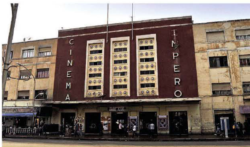
La facciata del cinema "Impero", con i caratteristici decori architettonici con cui venivano costruite le sale cinematografiche degli anni trenta.
