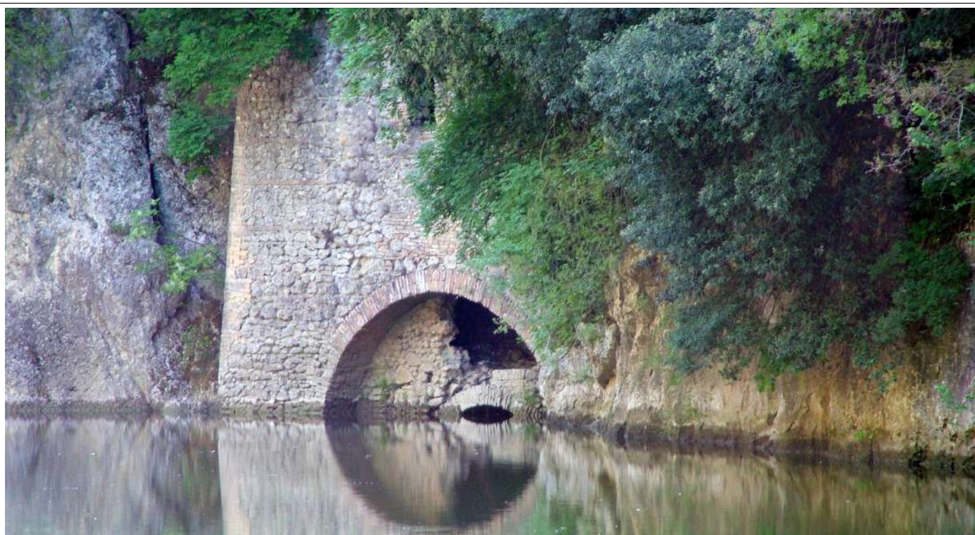
Un aspetto del bacino a valle con il mulino sottostante che mostra ancora l'antico arco entro il quale girava, mossa dall'acqua, la ruota motrice delle macine.
